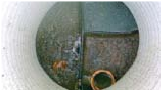
Bundfældningstank kort efter IKKE vellykket tømning (flydeslam i kammer 1 og 3)
