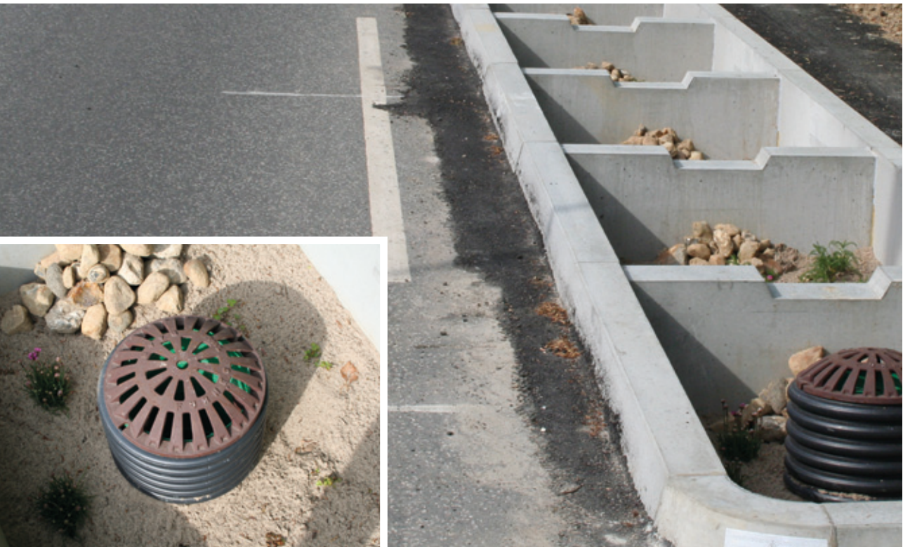
◀ Vertikalbrønden blev valgt, fordi den som den eneste på markedet, kan installeres på et lille areal
