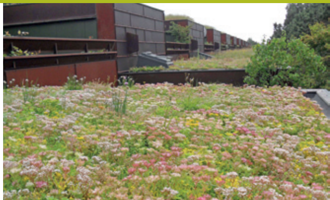
Grønt på taget er en effektiv regnvandsforsinker. DiaFlow sætter en bremse på op til 96 procent af vandet selv ved meget kraftig regn.
