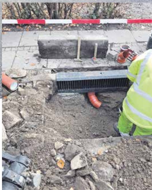
En kantstensrist bringes på plads ved Kliplev i Aabenraa Kommune.
