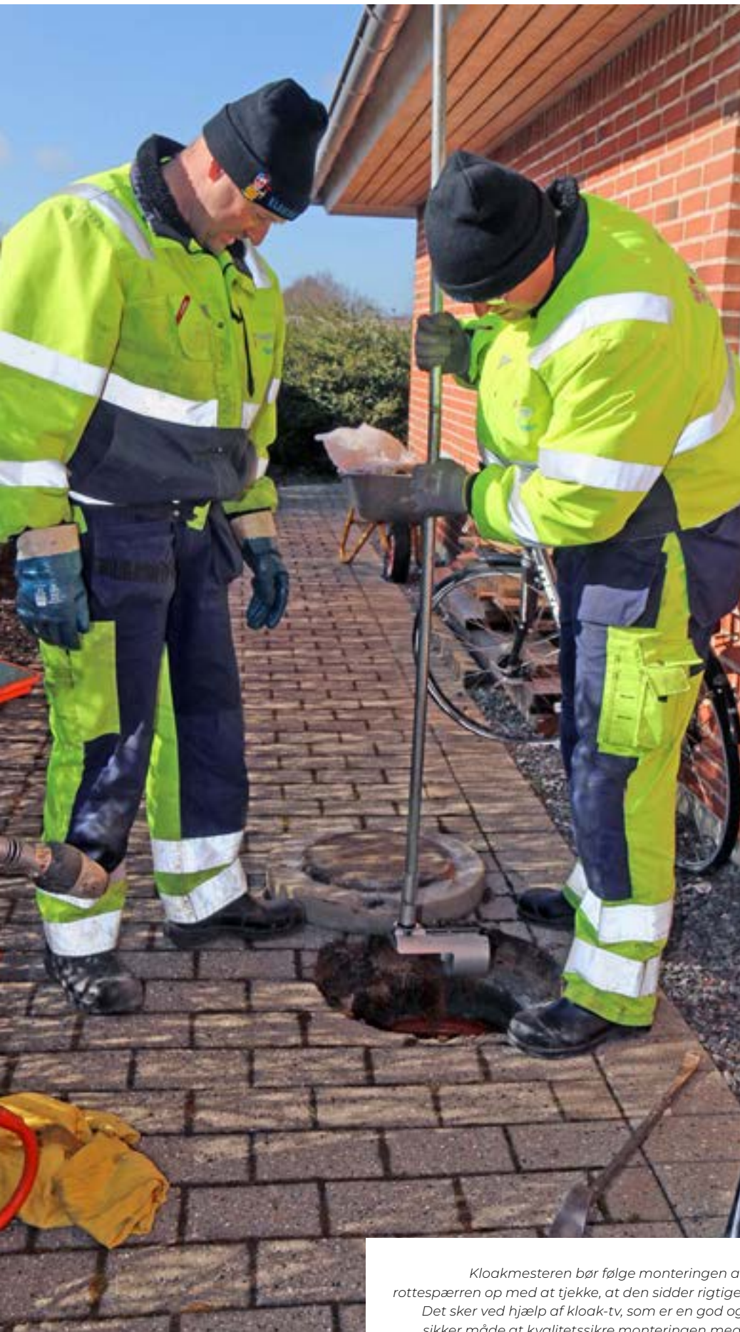
Kameraet nede i kloakken sender klare og tydelige billeder op til kloakmesteren, som kan konstatere, at rottespærren er monteret rigtigt.
