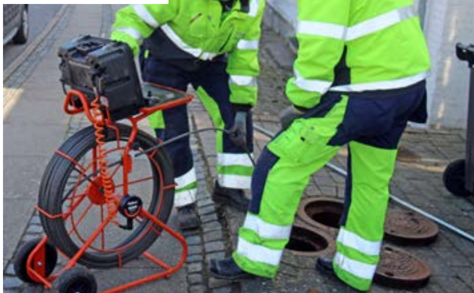
Rottespærren er nede og på plads. Monteringsstangen kan skrues af.
